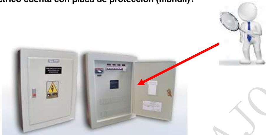
*Foto: tablero con mandil sin cables eléctricos expuestos*
