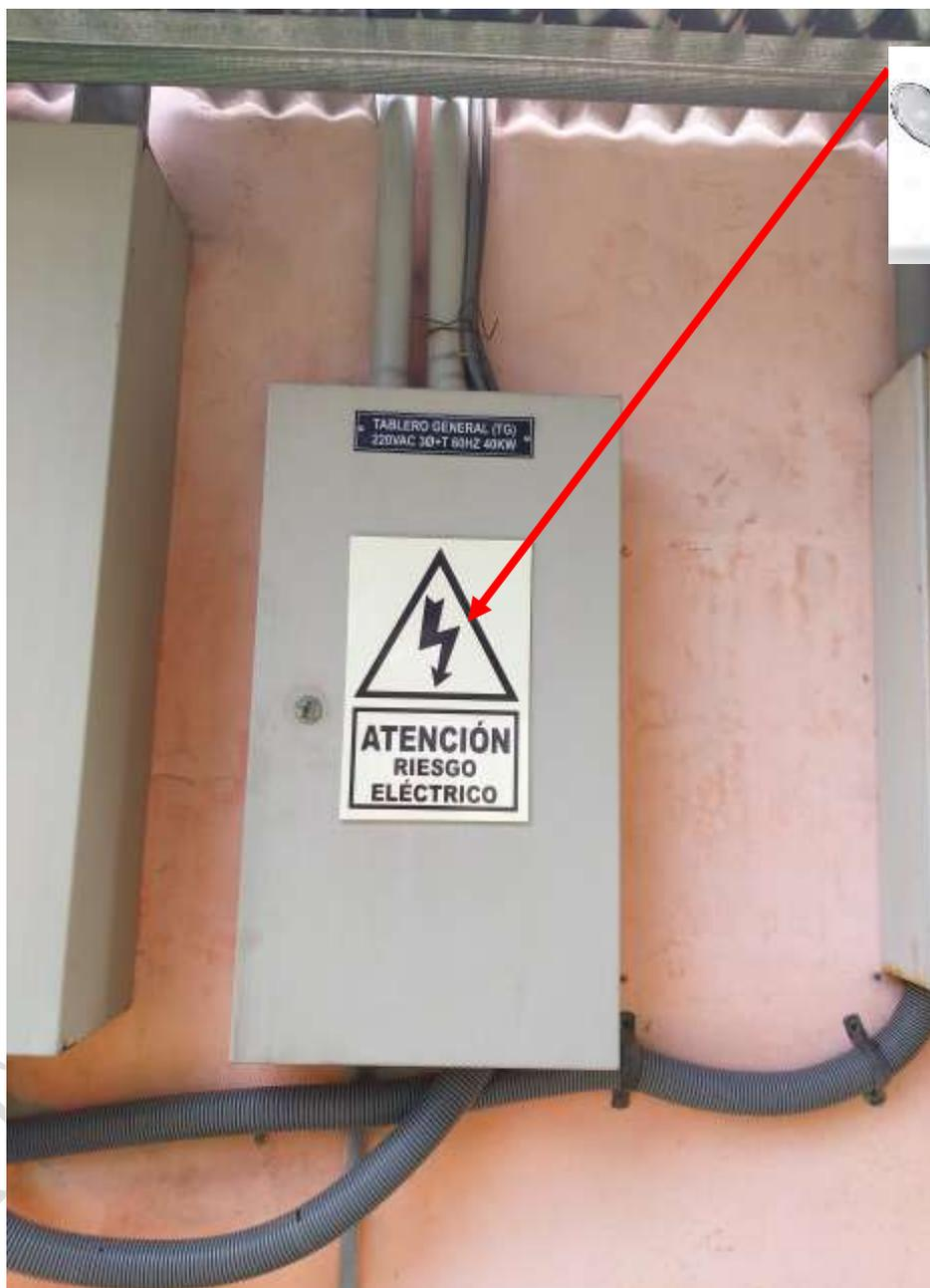
Foto: el tablero general tiene señalización de seguridad de riesgo eléctrico en la tapa
