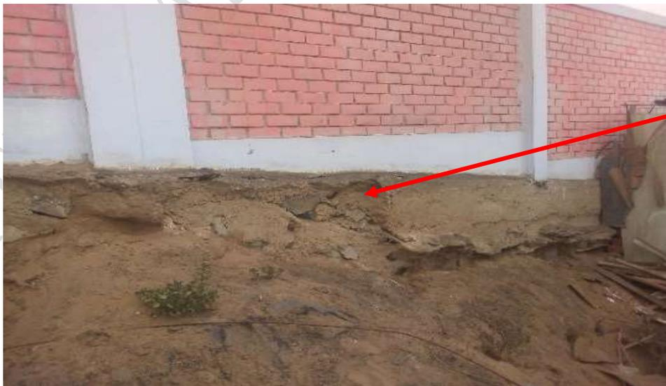
Foto: cimentación de cerco perimétrico se encuentra expuesta, en peligro de colapso
