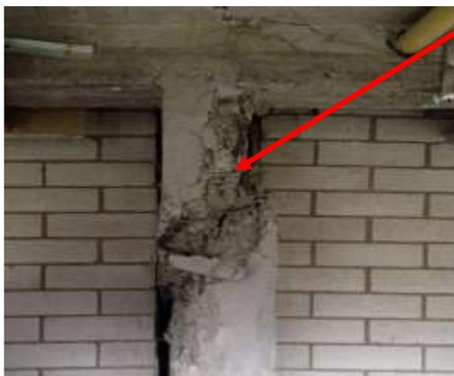
*Foto: columna fracturada*
