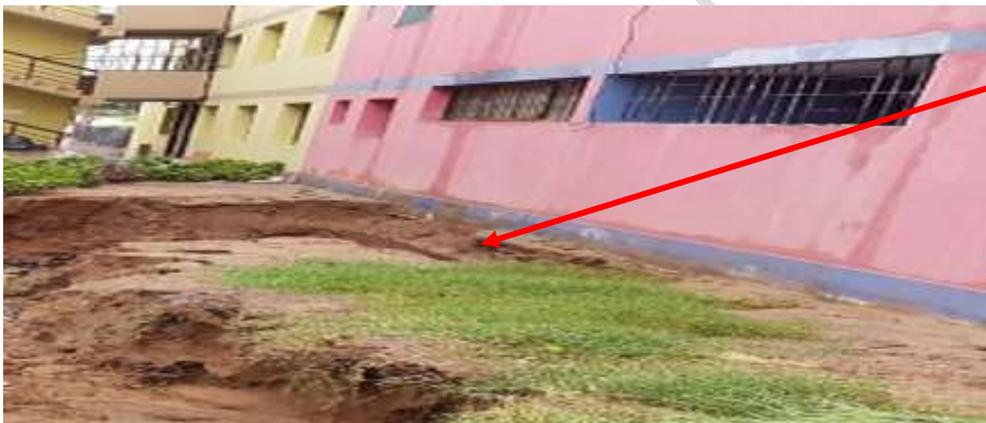
*Foto: cimentación expuesta como consecuencia de la erosión por lluvias*
