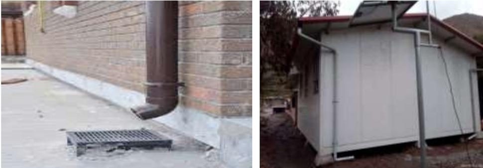
*Foto: El desfogue está conectado a la red pública de drenaje pluvial*
