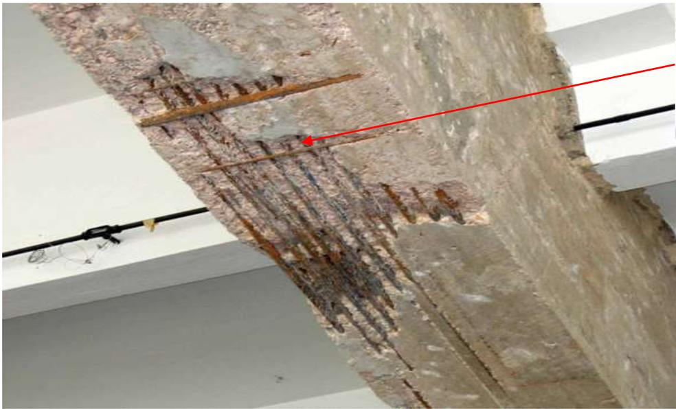
Foto: viga de concreto presenta deterioro por humedad producido por tuberías rotas
