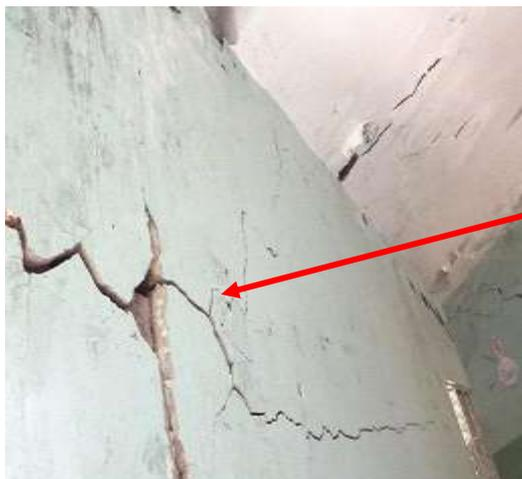
*Foto: muro agrietado*
