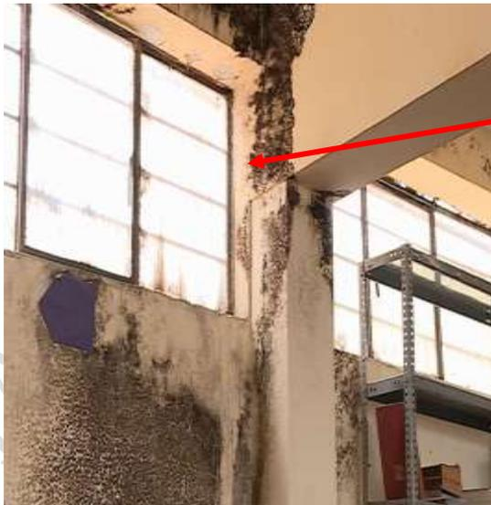
*Foto: muro y columna afectado por humedad*
