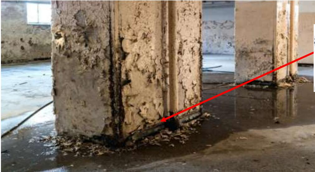
*Foto: cimentación expuesta por filtraciones de agua*
