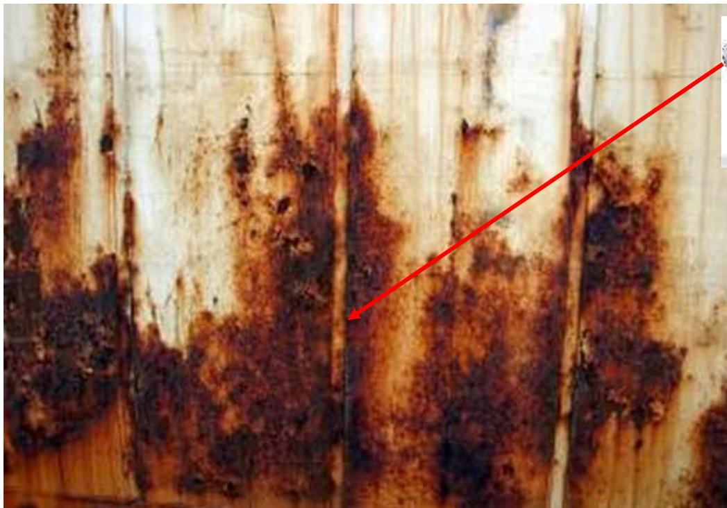
*Foto: defectos en las uniones de paneles*
