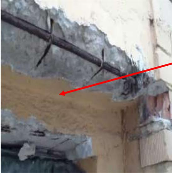
*Foto: vigueta agrietada*
