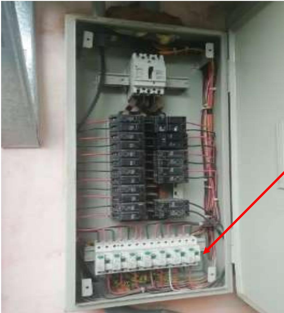
Foto: circuitos eléctricos con protección de interruptores diferenciales
