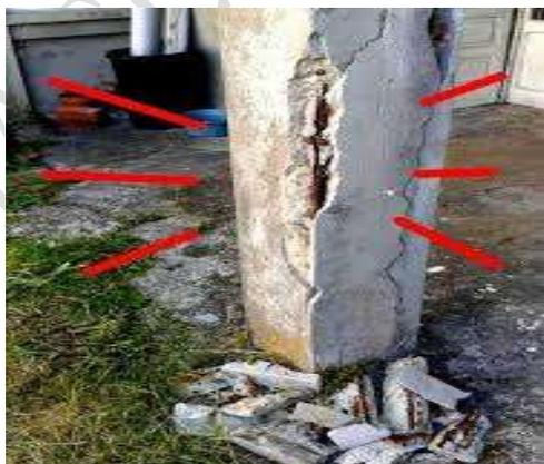
*Foto: columna fracturada*
