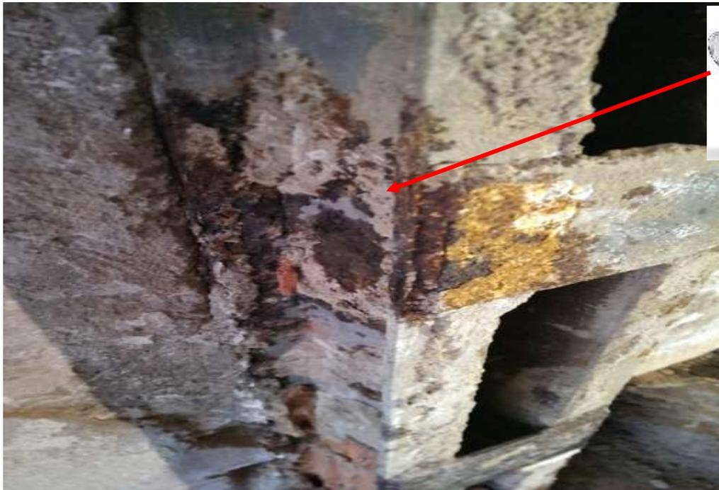
*Foto: deterioro por oxido o corrosión*
