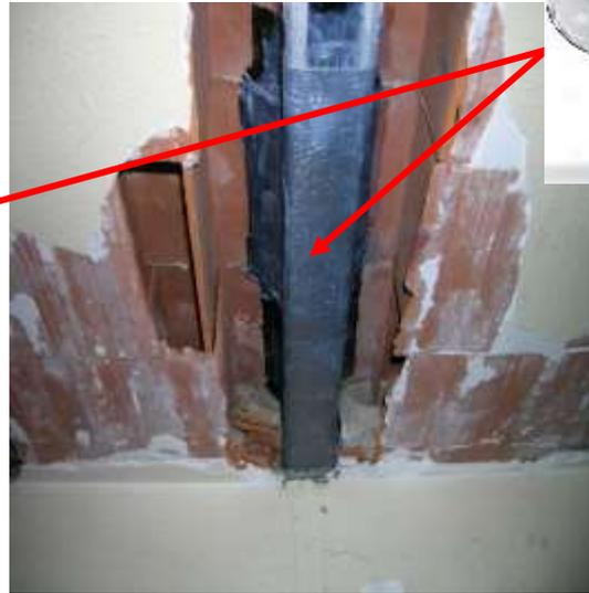
*Foto: viga agrietada*
