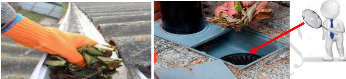
Foto: limpieza periódica de los sistemas de captación y drenaje
