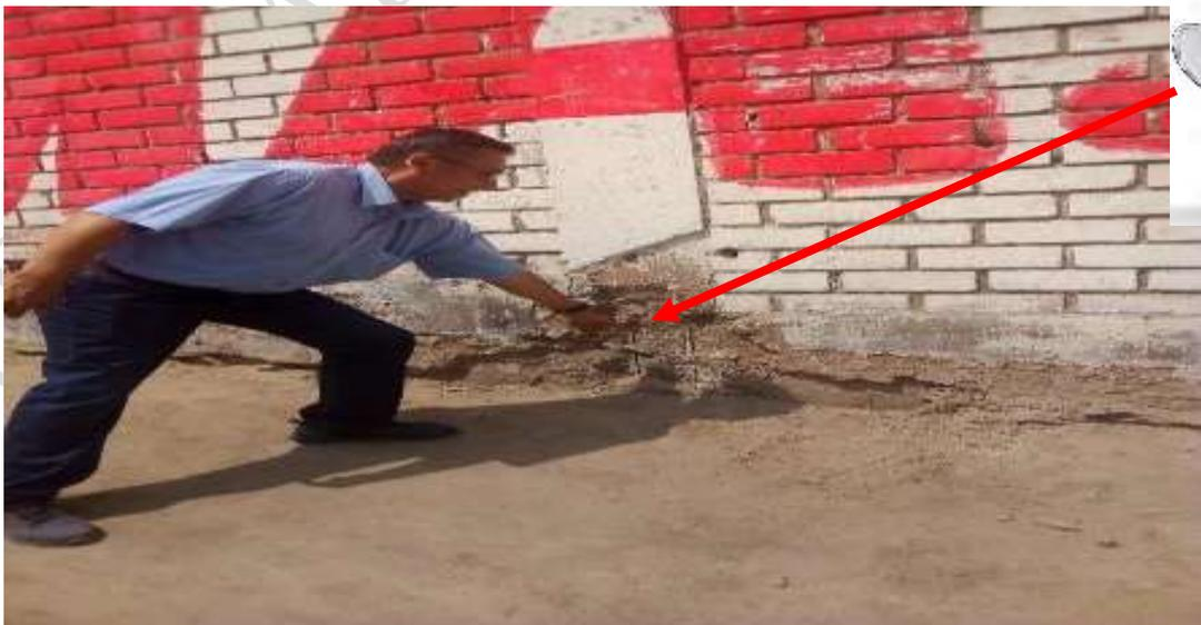
*Foto: cerco perimétrico de ladrillo presenta daños (varillas de acero expuestas a la intemperie)*
