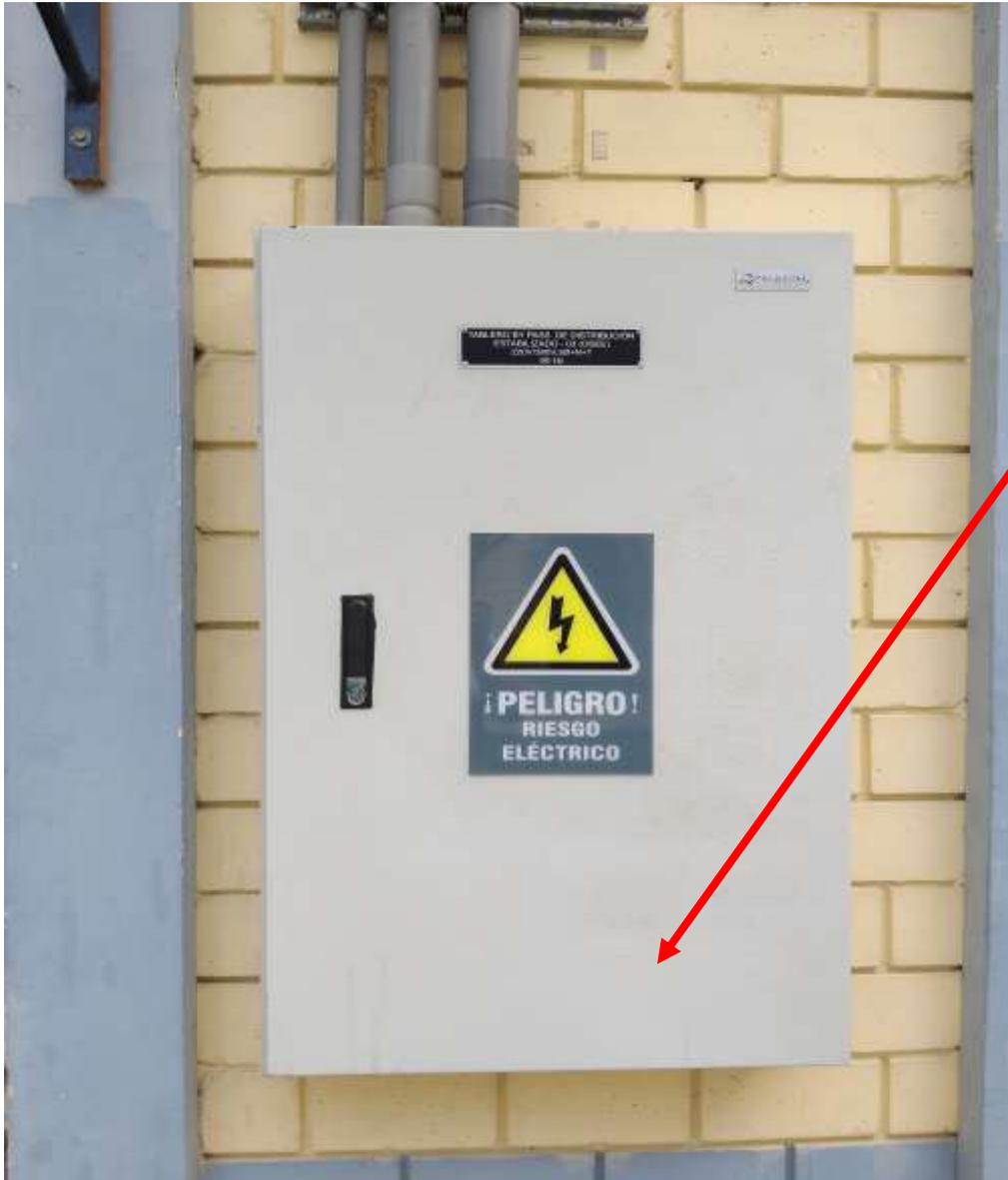
Foto: el tablero de distribución tiene señalización de seguridad de riesgo eléctrico en la tapa
