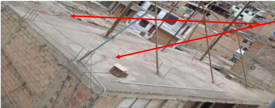
Foto: techo con varillas de acero expuestas
