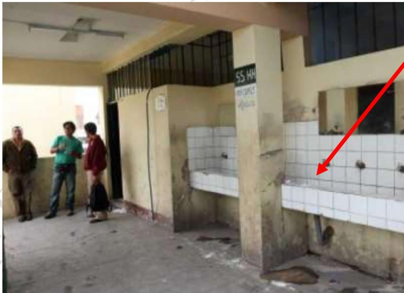
*Foto: falta de mantenimiento de instalaciones sanitarias*
